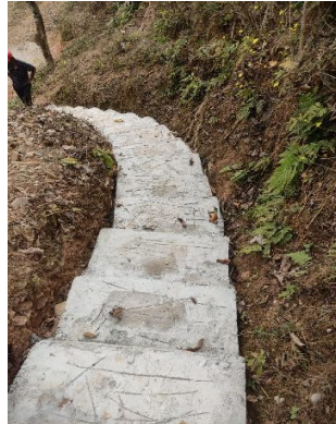
हिरापाटा तल्लाघरेको डहर गोरेटो बाटो निर्माण वडा नं १३
