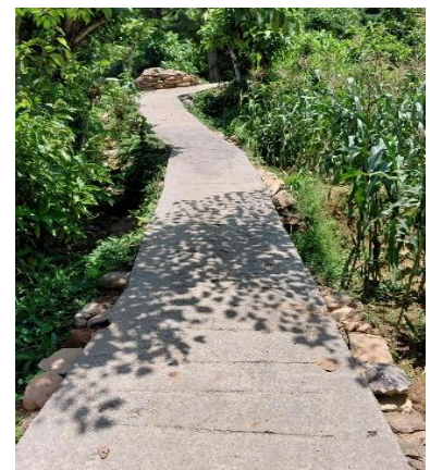
भकभके खोल्सी सिस्नेरी गाउँ जाने गोरेटो बाटो निर्माण वडा नं १३
