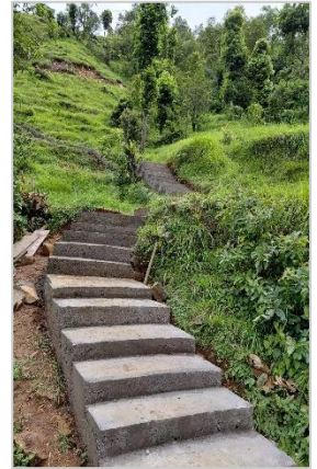
कंडेल गाउँ देखि लौसिबोट सम्म गोरेटो बाटो निर्माण, वडा नं ७
