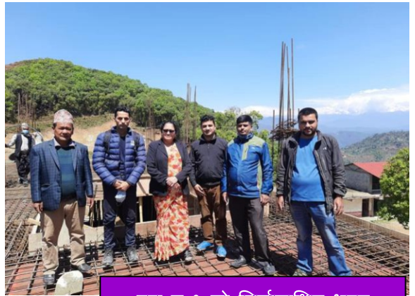
वडा न ९ को निर्माणाधिन भवन
